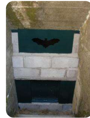
Aménagement d'un site à Audembert
